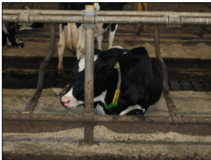
Abb. 4: Stützen sollten den Freiraum für den Kopfschwung nicht einschränken (Foto: Maiworm)
