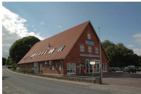
MarktTreff Gülzow – Das alte Bauernhaus wurde für 1,8 Mio Euro umgebaut und saniert. (Foto Rainer Kruse)
